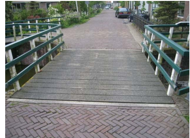
scenario 1: planken (en de slijtlagen) worden vervangen en conservering wordt in optimale staat gehouden.
