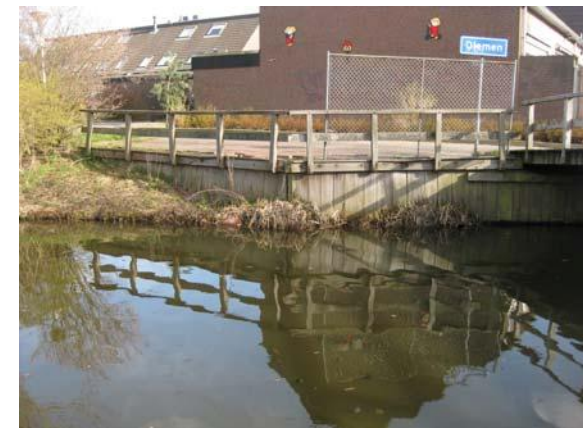
KA009: Vlasdonk Vervangen damwanden.
